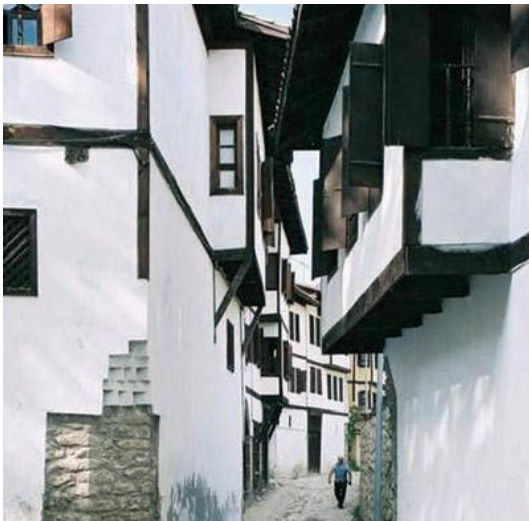
Bild 1 Traditionelle Fachwerkkonstruktion in der Türkei [6]
